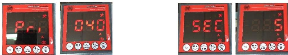
3. **A CONTINUACION LA BATERIA REALIZARÁ AUTOMATICAMENTE LA AUTOADQUISICION DE ESCALONES, PARA COMPROBAR Y REGULAR LA POTENCIA DE CADA UNO DE LOS CONDENSADORES, ESTE PROCESO NORMALMENTE OCURRE TRES VECES.**
